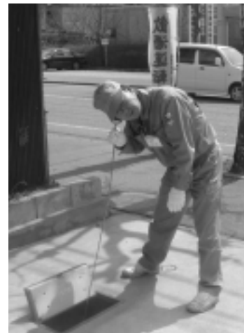
水の音で漏水チェック
