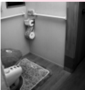
手すりを取り付け、段差を解消したトイレ
