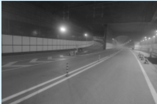
中央街区出口付近。左方向へ行くと出口
