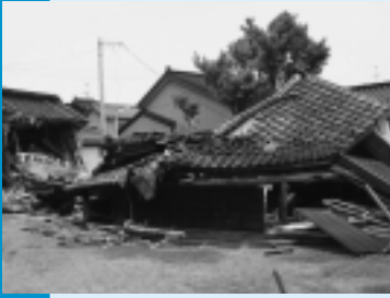
平成19年の新潟県中越 沖地震で倒壊した家屋
