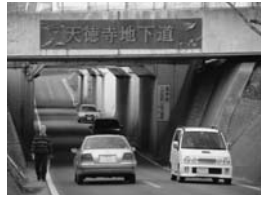
天徳寺地下道
