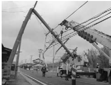
暴風で折れた電柱の復旧作業 (下浜の国道7号)
