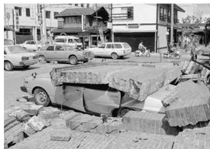
日本海中部地震での被害
