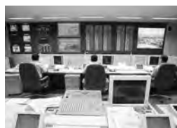
消防の通信指令室
