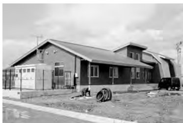
工事中の園芸振興拠点施設の一部
