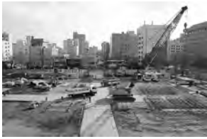
新庁舎工事現場
