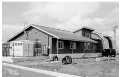
工事中の園芸振興拠点施設の一部
