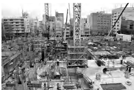
新庁舎工事風景。建物の形が見えてきました
