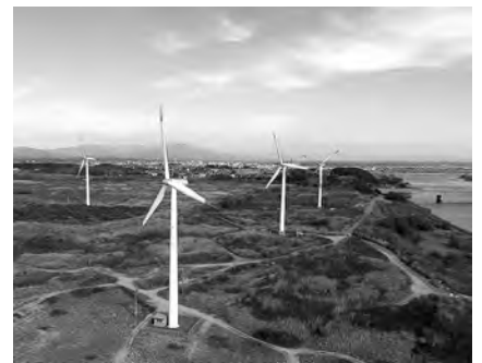
自然の恵みをエネルギーに (雄物川河口付近の風車群)
