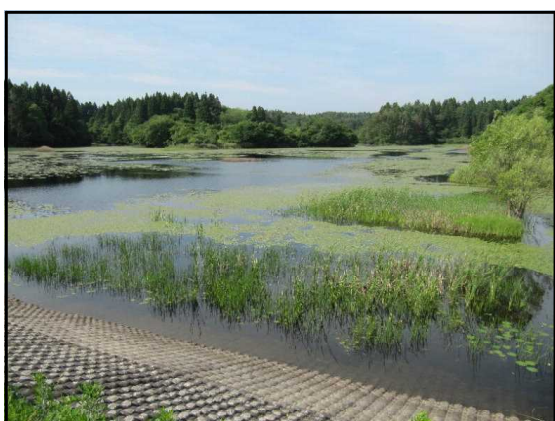
待入堤近景（南西から）
