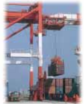
秋田港のガントリー・クレーン
