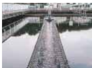
八橋下水道終末処理場(秋田市)
