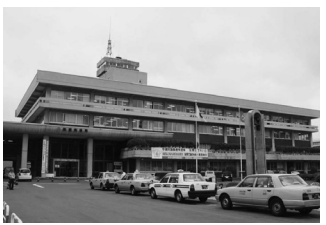
市役所本庁舎(昭和39年築)
