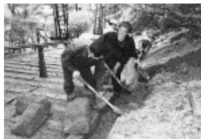
市石材加工組合のみなさんが石垣の組み直し
