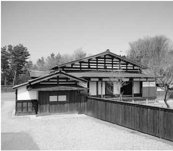
主屋は座敷棟・小座(おござ)・台所棟の三棟を接合した建物
