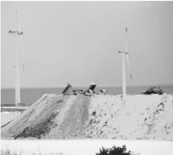
堆雪場は雪の山...(3月3日、旧空港跡地)
