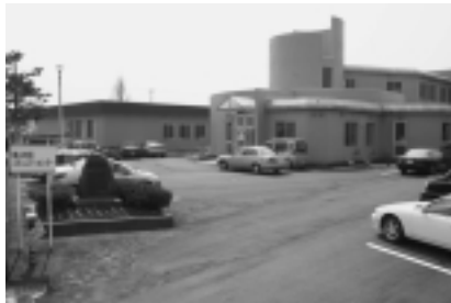
左手奥が居室棟
