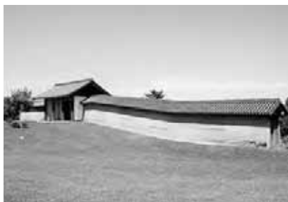
平成10年に復元された外郭東門と築地堀(土を突き固めて造った堀)。
