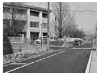
飯島中学校正門前の道路工事が完了し、安心安全な通学路ができました
