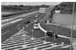
完成後の雄物大橋
