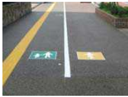
路面に設置した例
