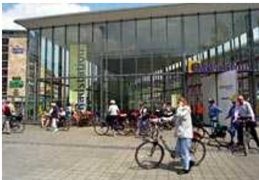
自転車ステーションの外観
