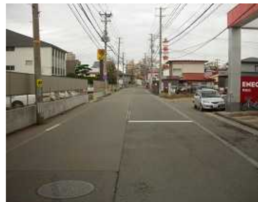
四丁目橋線 現況写真(対面通行区間)
