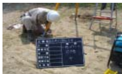
地際の防蝕処理
