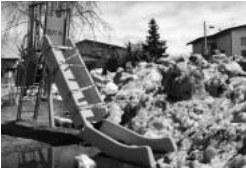
被害が大きかった公園施設
