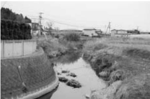
整備計画の早期策定が望まれる堀内2号橋上流
