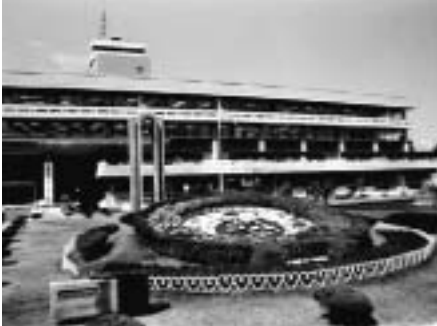
市庁舎の耐震診断を行い整備計画を検討します
