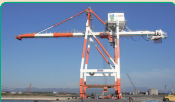
2号ガントリークレーン
