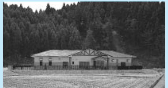
上新城地区に完成した処理施設
