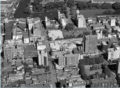
再開発が本格的に始動する日赤・婦人会館跡地
