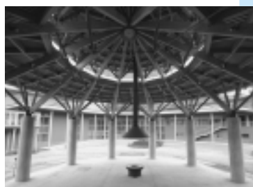
大屋根研修棟
