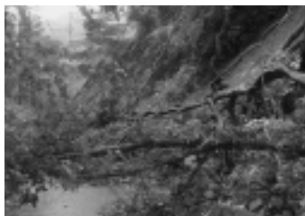
大雨で土砂が道路に(7月3日、市道上八田大根沢線)
