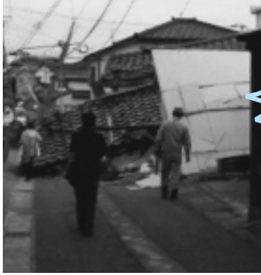
7月18日、新潟県柏崎市の倒壊建物
