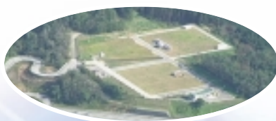
手形山配水場
