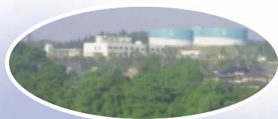
豊岩浄水場・配水場
