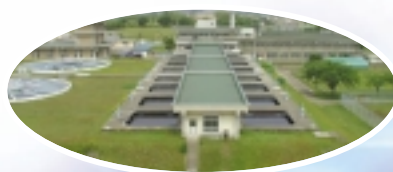
仁井田浄水場
