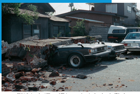
倒壊した塀で押しつぶされた自動車
