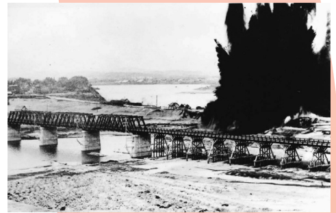
爆破による通水
