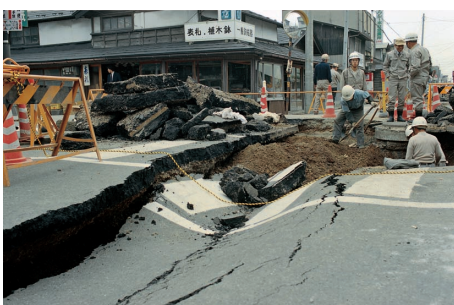
大町では道路が陥没しました
