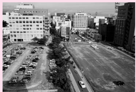
建設予定地の日赤・婦人会館跡地
