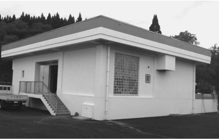
雄和ポンプ場(雄和浄水場敷地内)
