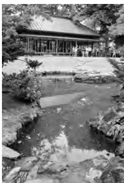
如斯亭庭園。整備工事は平成29年完了の予定
