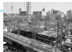
建設中の新庁舎
