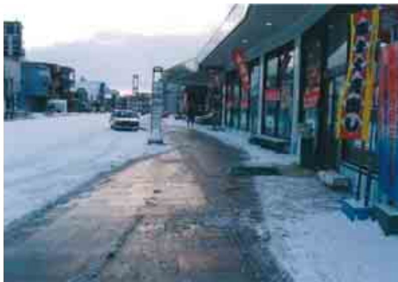
▲歩道消融雪の稼働状況
