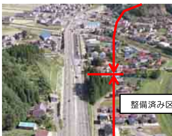
▲ 21 一般国道13号河辺拡幅
