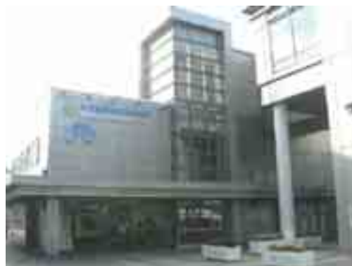
▲秋田駅東自転車等駐車場
