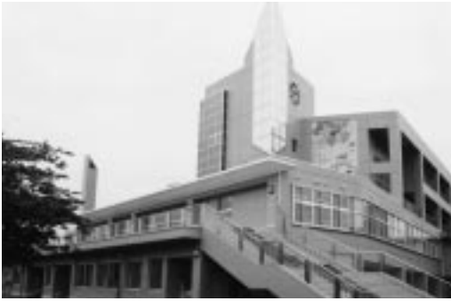
グラウンドを築造する勝平小学校
