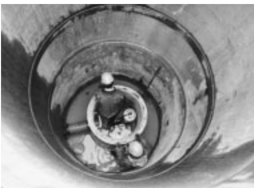
下水道建設工事
