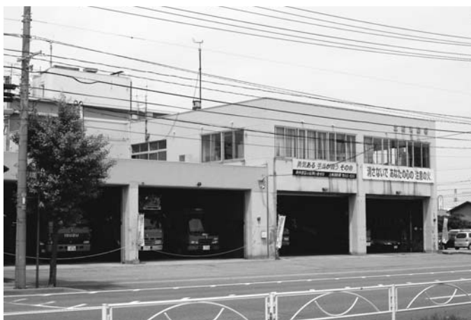
老朽化が進んでいる土崎消防署
