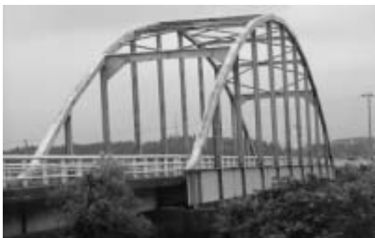
通行止めになっている本田橋
