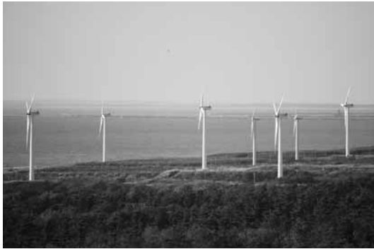
新屋地区にある風力発電
