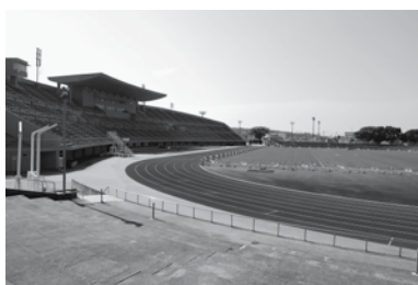
秋田市八橋運動公園陸上競技場
