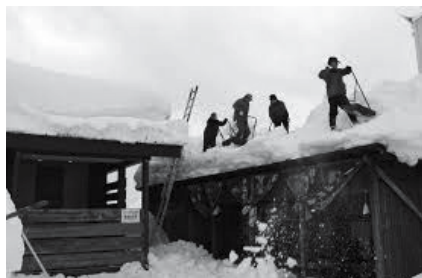
屋根の雪下ろし作業
