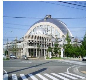
3. 市立体育館 (八橋本町)
